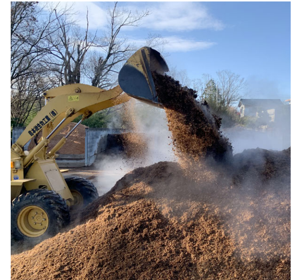
5. 材料が均一に混ざるようにホイールローダーなどで混合します。 その後発酵を促すため堆肥舎に積み込みます。
